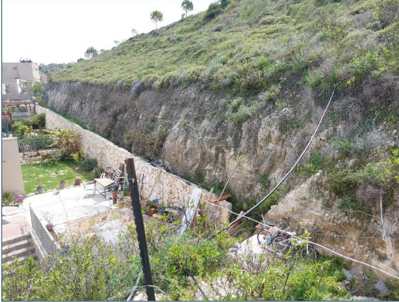
תמונה 6- מדרונות חצובים עם ברגי סלע ורשתות פלדה בחצרות מבני "קול צופיך" (צולם לכיוון דרום)
