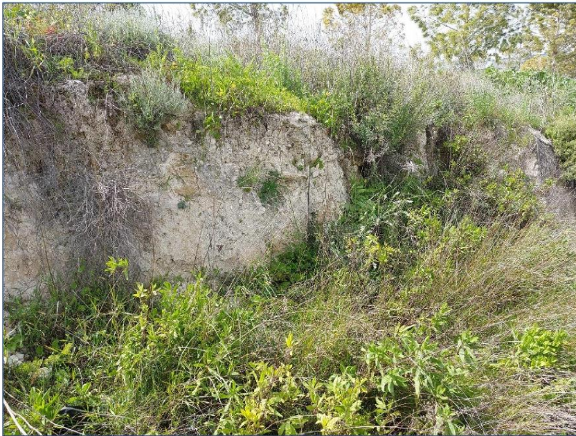
תמונה 7- מילוי לא מבוקר מעודפי עפר וחציבות מקומיים
